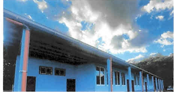
Foto 2: Sustrucción de ventanas por ventanas de PVC
