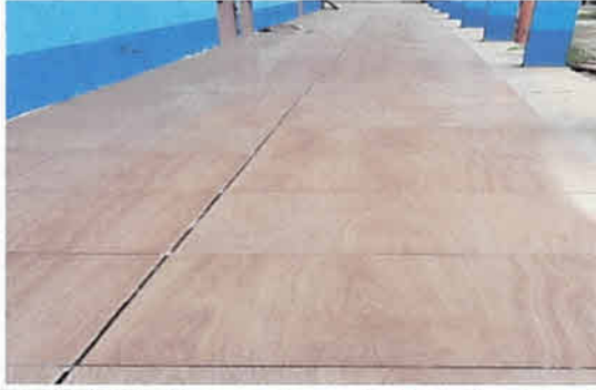
Foto1: Sustrucción de piso cemento por piso de granito.
